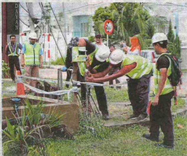
PEGAWAI Span menyita sambungan paip air yang tidak sah.
